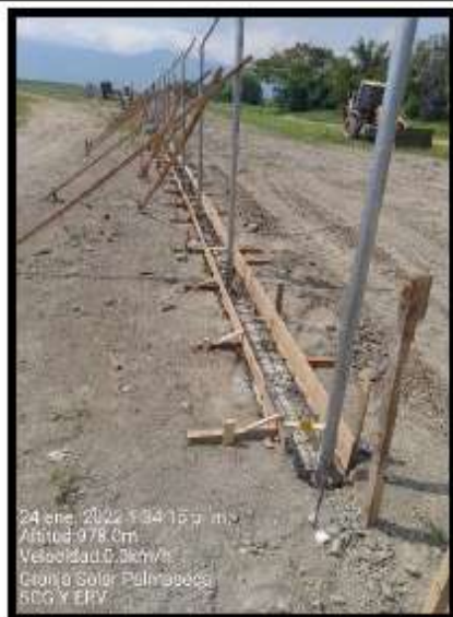
Fotografía 13. Instalación de tubo galvanizado.
