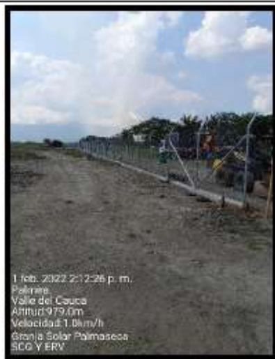
Fotografía 15. Instalación de malla eslabonada
