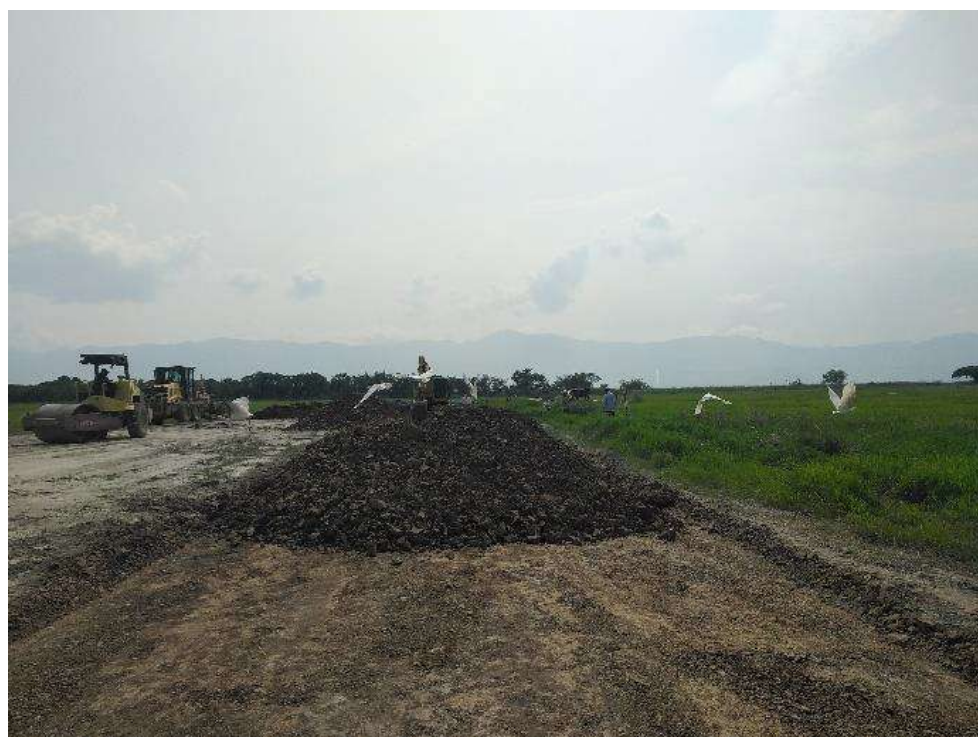
Adecuación de vías internas
