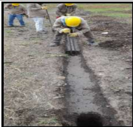
Fotografía 11. Excavación de micropilotes
