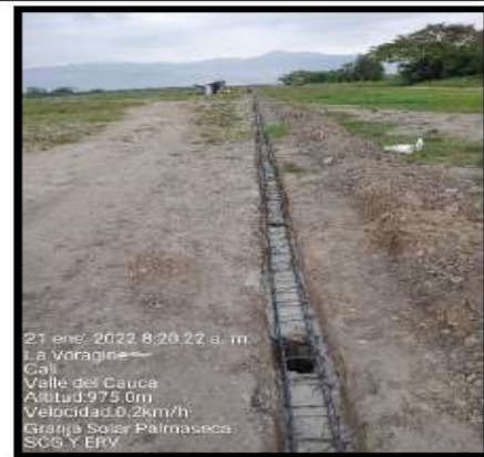
Fotografía 12. Instalación de parrilla de acero de viga de cimentación.
