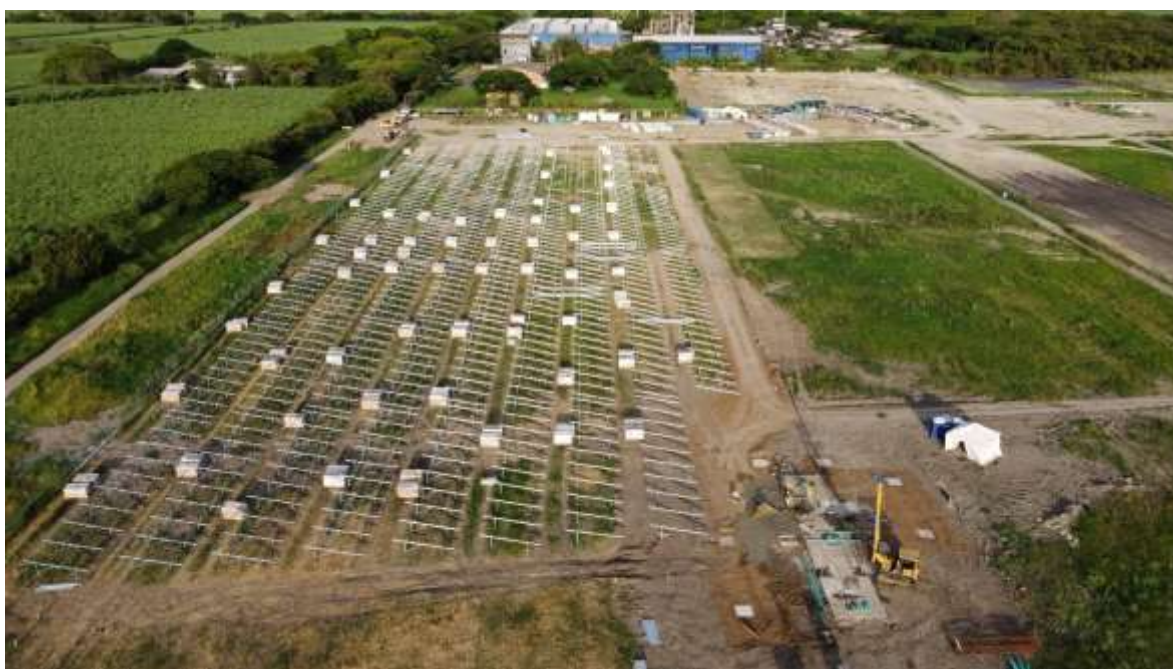
Trabajos de localización topográfica de hincas e instalación de pilares
