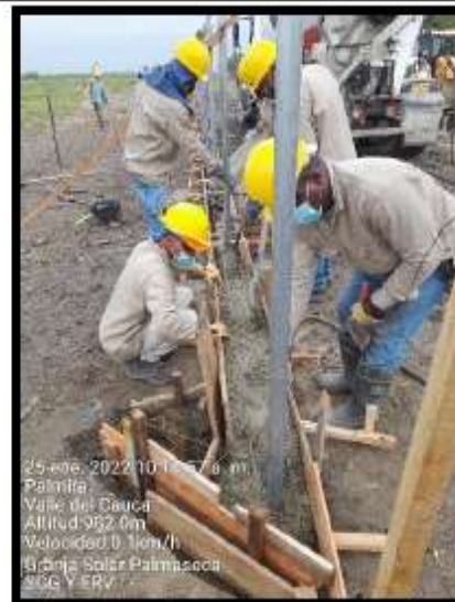
Fotografía 14. Fundición de viga de cimentación y micropilotes.
