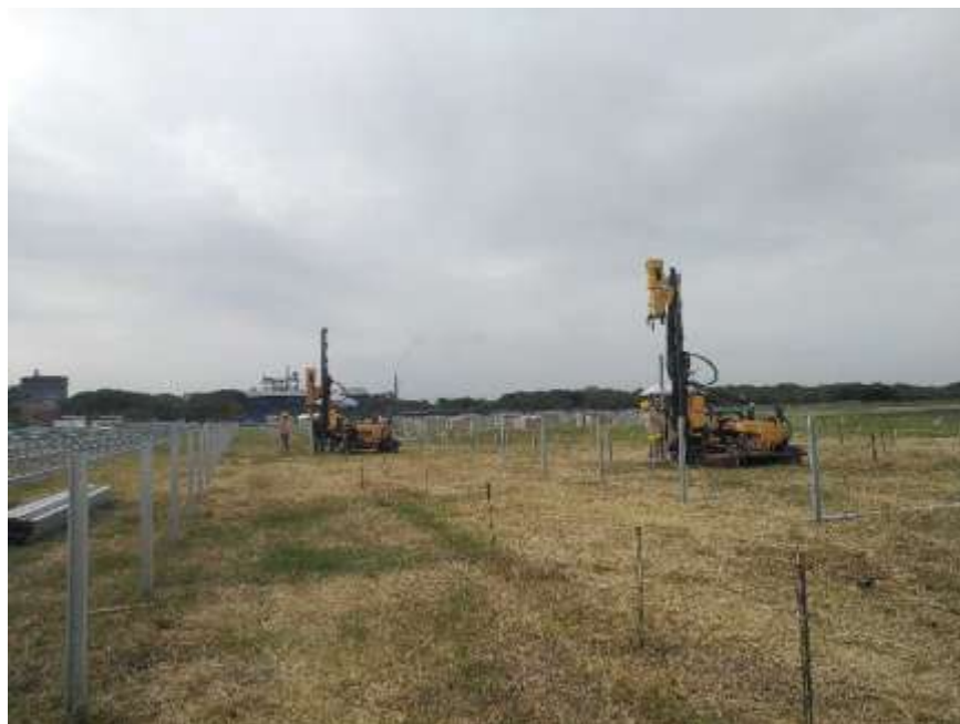
Trabajos de localización topográfica de hincas e instalación de pilares
