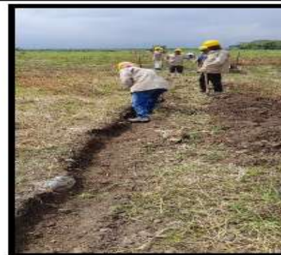
Fotografía 10. Excavación de viga de cimentación
