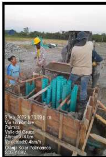
Fotografía 2. Fundición de caja recolectora de ductos DC
