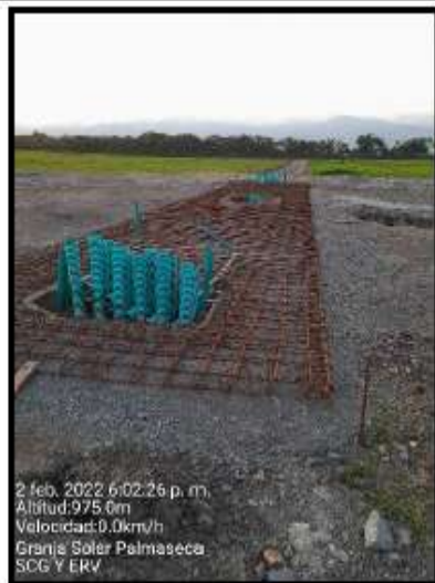
Fotografía 1. Instalación de acero de refuerzo para losa de inversor.
