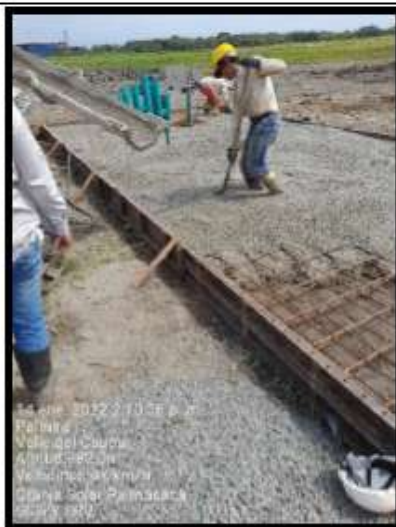
Fotografía 3: Fundición de Losa A para inversores del subcampo 1
