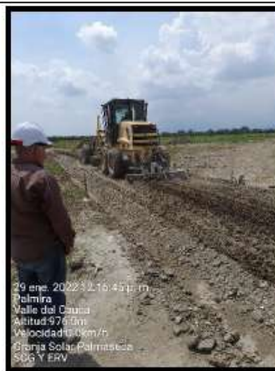
Fotografía 4. Proceso de penteración previo para aplicación de estabilizante Tx
