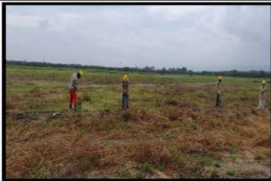
Fotografía 9. Excavación de viga de cimentación de cerramiento y micropilotes
